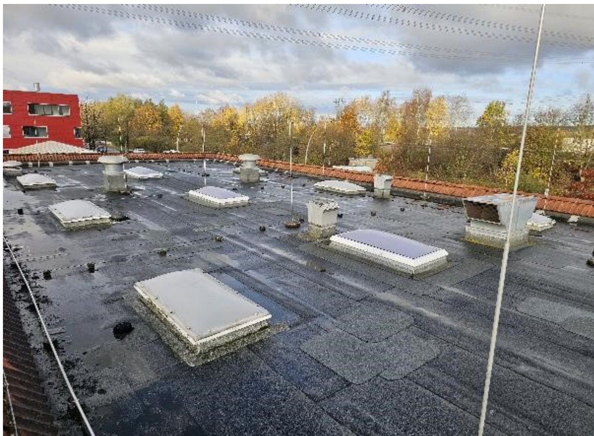
Abb. oben/unten: Teilbauabschnitt 04 von der Treppe aus gesehen, alte Lichtkuppeln und relativ neue neue RWA in der mittleren Reihe
