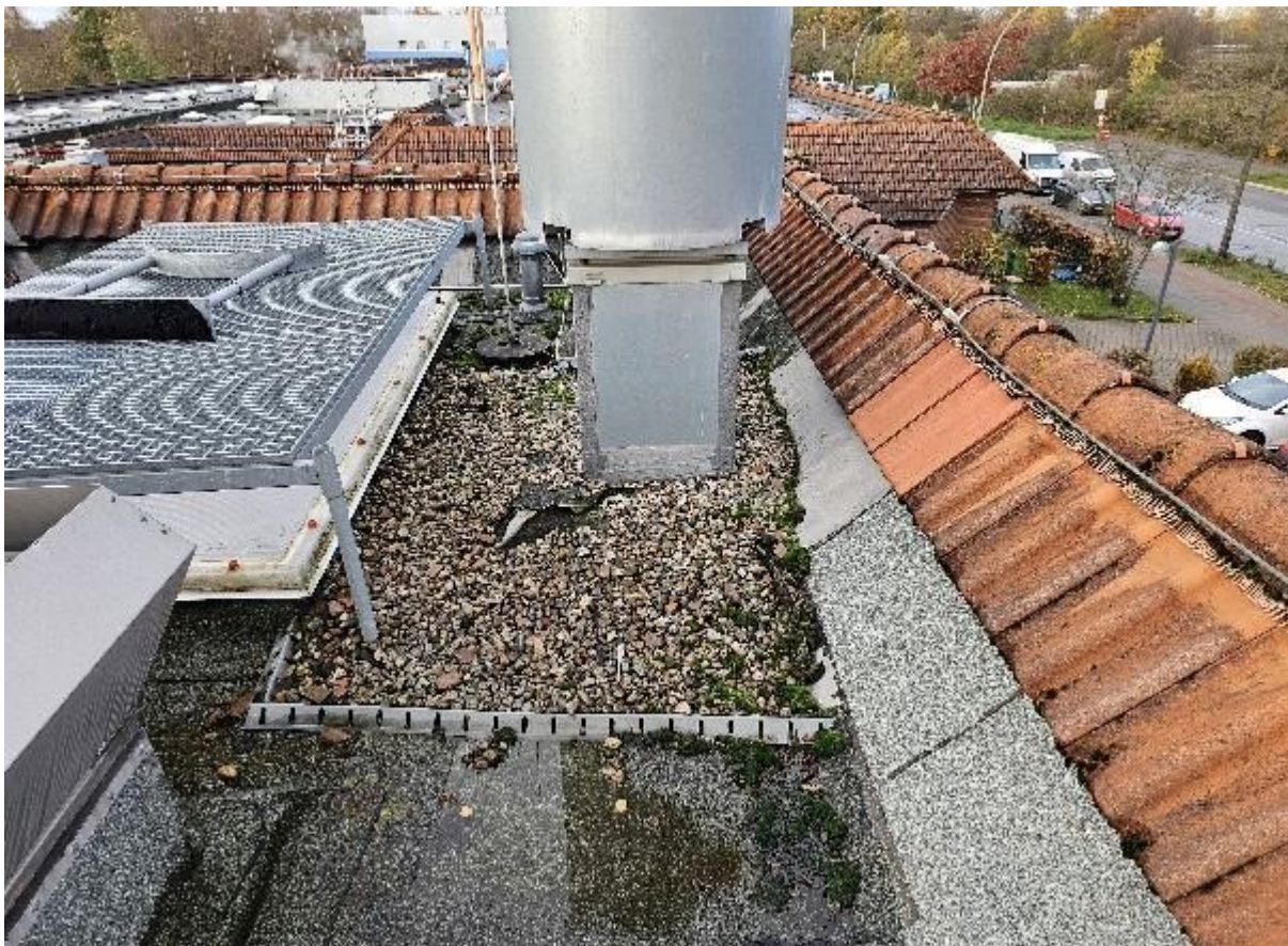
Abb. oben/unten: Teilbauabschnitt 07 Dach über Kantine mit Lüftungseinbauten, Kies und Lichtkuppel mit Schutz-GiRo
