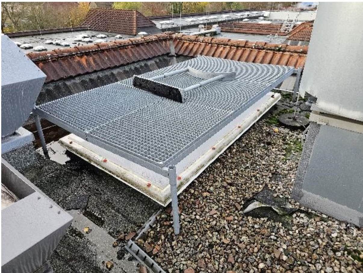
Abb. oben/unten: Teilbauabschnitt 07 Dach über Kantine mit Lüftungseinbauten, Kies und Lichtkuppel mit Schutz-GiRo
