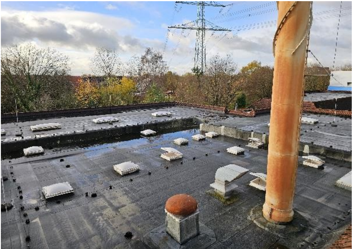
Abb. oben: im Vordergrund Teilbauabschnitt 02 mit abzubrechendem Schornstein, Lüftungskanälen, Lichtkuppeln usw. Im Hintergrund und rechts hinter dem Höhenversprung Teilbauabschnitt 1. Rechts hinter dem Schornstein ist die Kaltlager im Anschnitt zu sehen.
