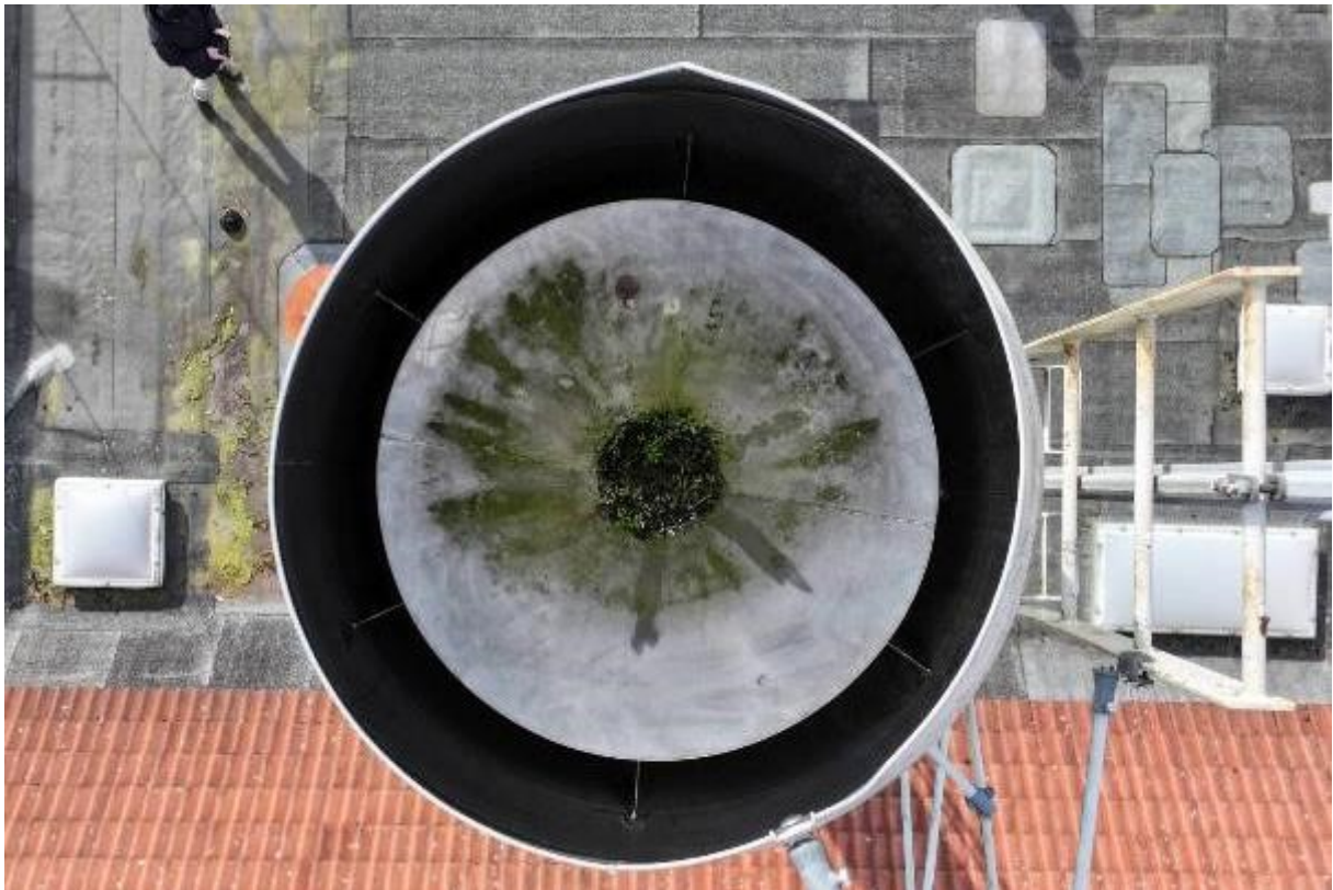
Abb. oben/unten: abzubrechender Schornstein von oben/schrägober mit Aufsteigeleiter, Scruton-Wendel, Haube, Blitzableitungen
