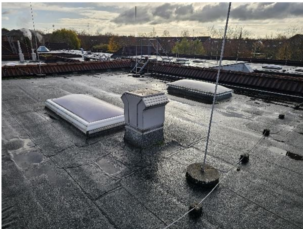
Abb. oben/unten: Teilbauabschnitt 04 von der Treppe aus gesehen, alte Lichtkuppeln und relativ neue neue RWA in der mittleren Reihe
