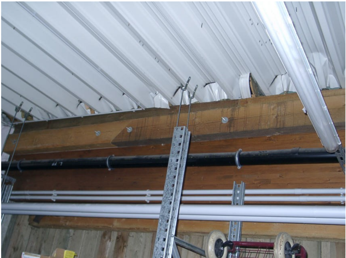
Abb. oben/unten: festgestellte mangelhafte Altausführung des Trapezbleches im Auflagerbereich
