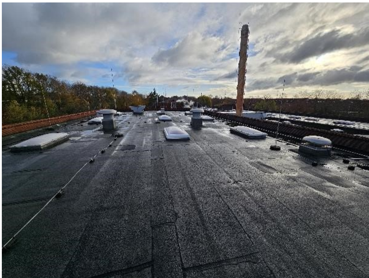
Abb. oben/unten: Teilbauabschnitt 04 mit aufgelegter Leiter von Teilbauabschnitt 02, Lichtkuppeln und Lüftungseinbauten
