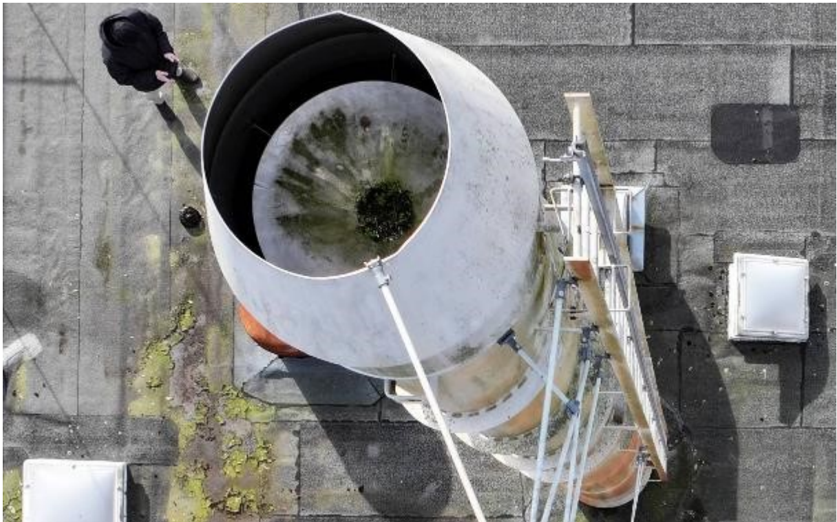
Abb. oben/unten: abzubrechender Schornstein von oben/schrägober mit Aufsteigeleiter, Scruton-Wendel, Haube, Blitzableitungen
