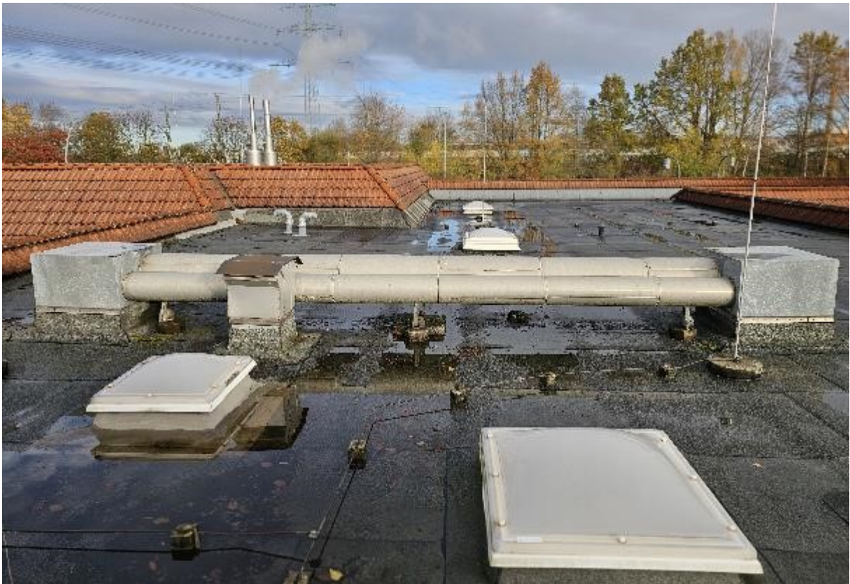
Abb. oben/unten: Teilbauabschnitt 05 zwischen den beiden Atrien mit Lüftungseinbauten und Dachkuppeln
