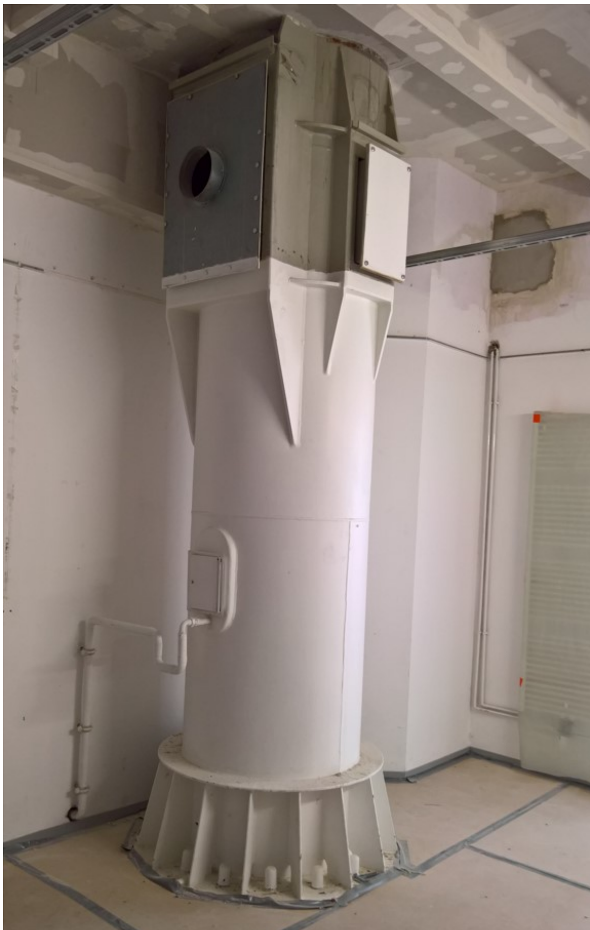
Abb. oben: abzubrechender Schornstein im Gebäude, Bild zeigt den damaligen Zustand vor dem Einbau einer Brandschutzeinhausung
